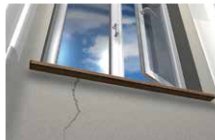
Vyplňování prasklin ve zdivu
