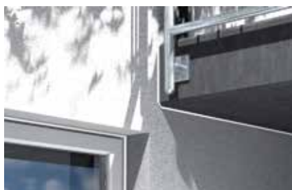
Styčné spáry v exteriéru
