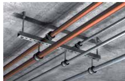
Duté betonové desky
