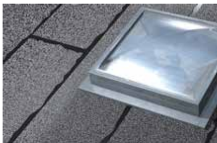
Utěsňování spár u střešních oken
