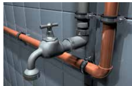
Instalace sanitárního vybavení
