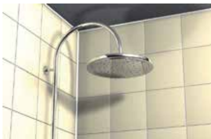
Vyplňování spár v sanitární oblasti
