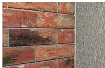
Dilatační spáry mezi budovami
