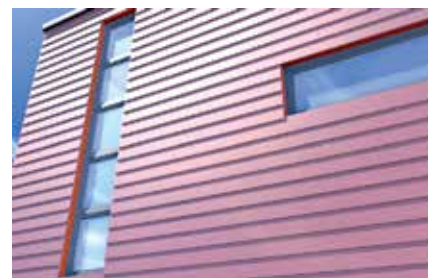
Nosné konstrukce fasád
