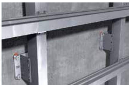
Nosné konstrukce fasád
