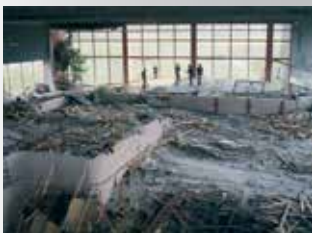
V roce 1985 povolil zavěšený betonový strop krytý plovárnou v Usteru, ve Švýcarsku. Stropní spojovací prvky z nerezavějící oceli nevykazovaly žádné vnější známky poškození, ale uvnitř byly v některých případech zcela zničeny v důsledku popraskání způsobeného korozí napětím
