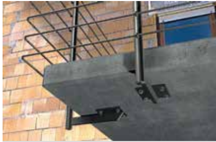
Upevnění zábradlí
