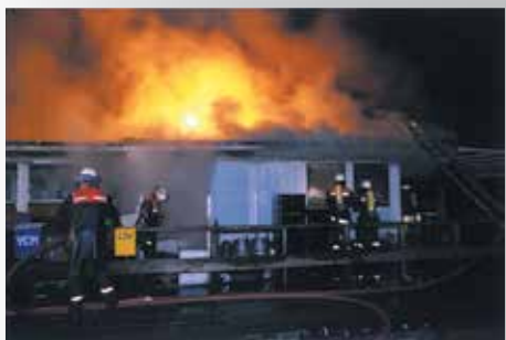
Požár restaurace Aussenalster v Hamburku Budova: Převážně dřevěná, jednopatrová, Postavená na dřevěných pilotech Příčina požáru: Technická závada elektroinstalace, pravděpodobně následkem únavy materiálu Škody na budově: Zničení až na piloty a trámový rošt Výše škody: cca. 0,5 mil. EUR
