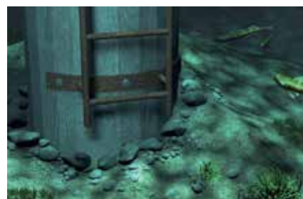
Montáže pod vodou
